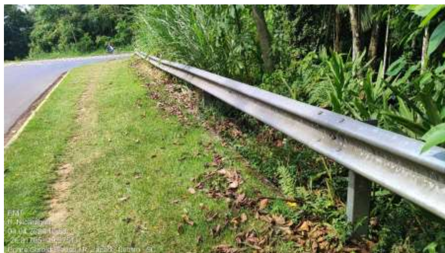
Figura 3 – Estado atual da calçada
