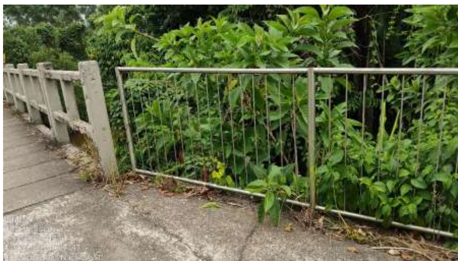
Figura 5 – Cabeceira da ponte da Rua Japão
