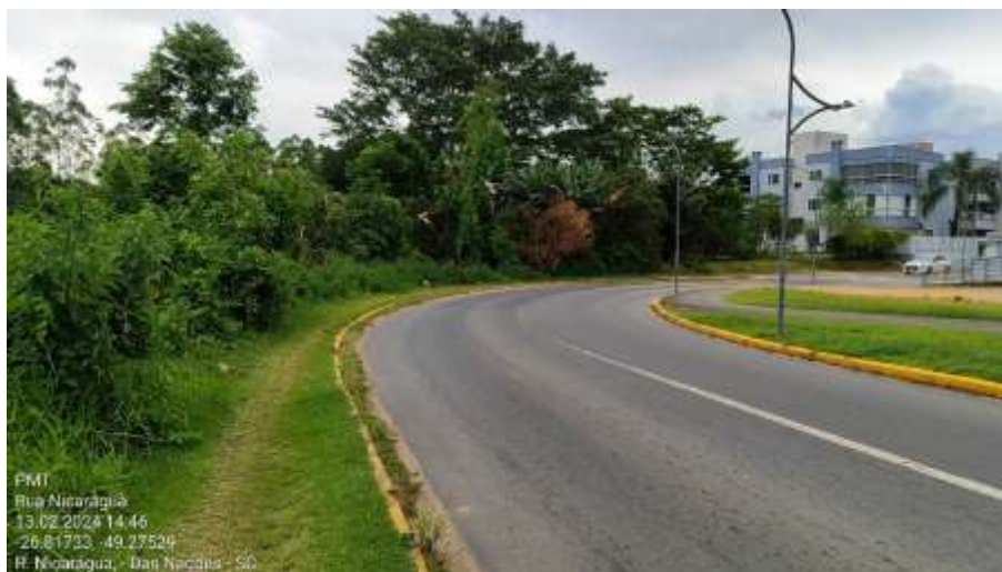
Figura 2 – Estado atual da calçada
