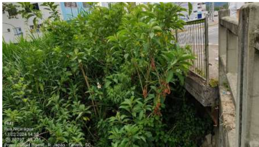
Figura 4 – Cabeceira da ponte da Rua Japão
