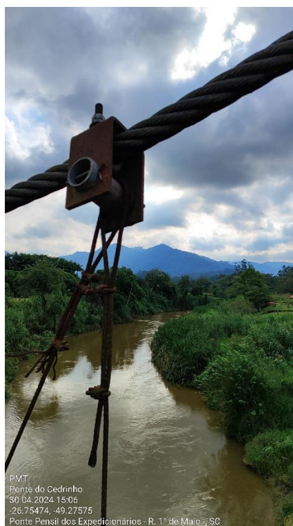
Figura 10 – Detalhe do aparelho de fixação dos pendurais
