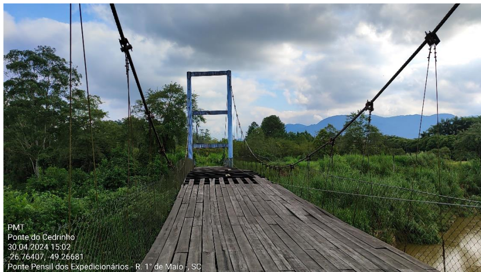
Figura 2 - Tabuleiro da ponte
