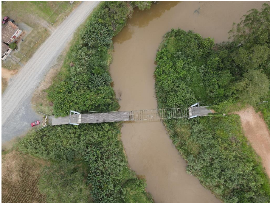
Figura 9 – Vista superior da ponte
