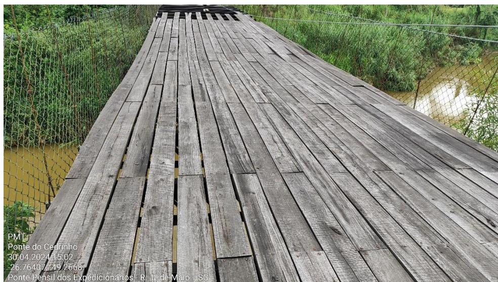
Figura 3 – Tabuleiro da ponte
