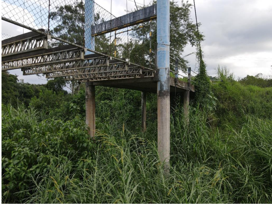
Figura 8 – Detalhe da cabeceira de apoio
