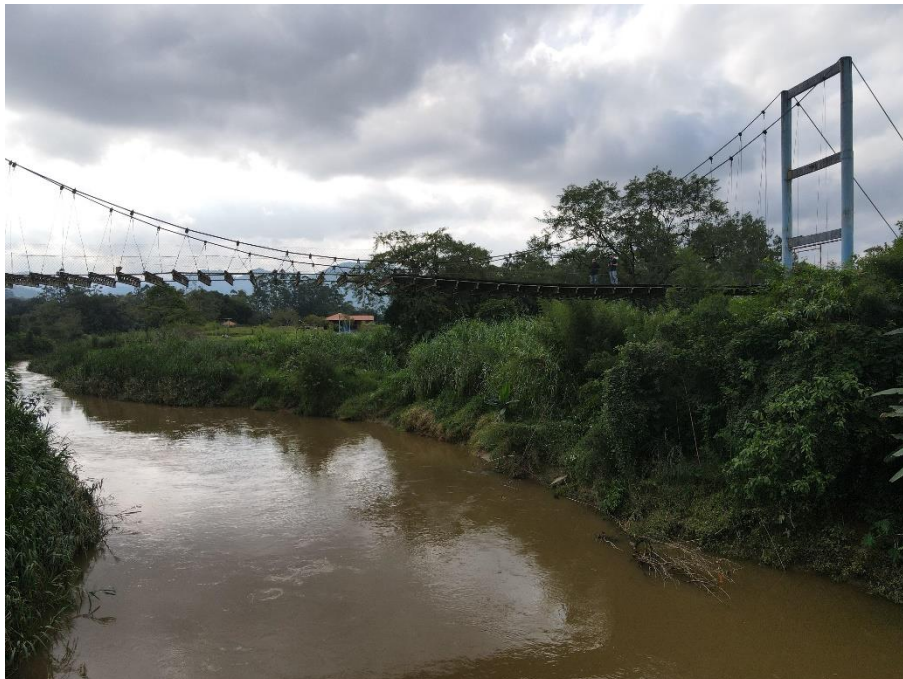
Figura 7 – Vista lateral da ponte
