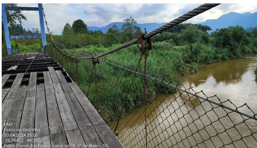
Figura 11 – Detalhe do guarda-corpo, pendurais e aparelhos de fixação dos pendurais
