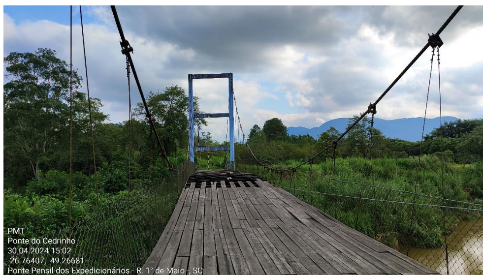
Figura 2 - Tabuleiro da ponte
