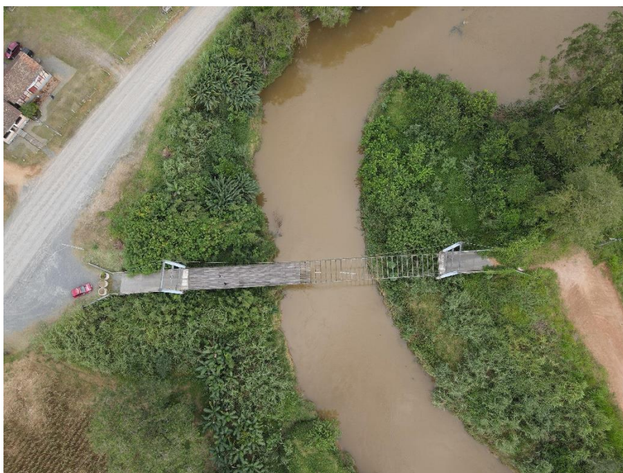
Figura 9 – Vista superior da ponte
