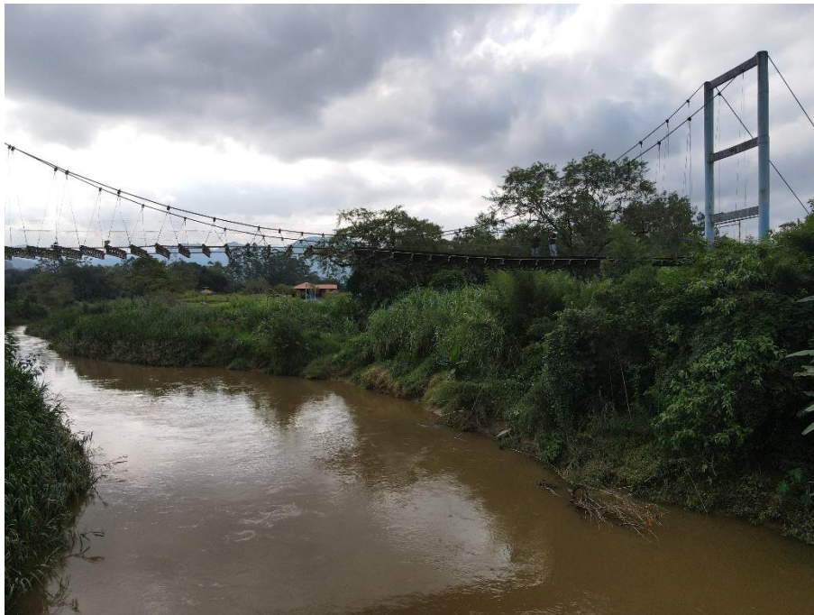
Figura 7 – Vista lateral da ponte
