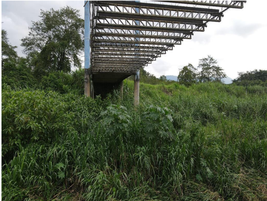
Figura 6 – Transversinas metálicas existentes
