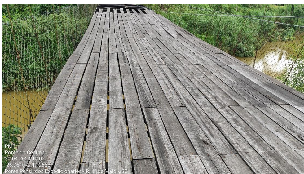
Figura 3 – Tabuleiro da ponte
